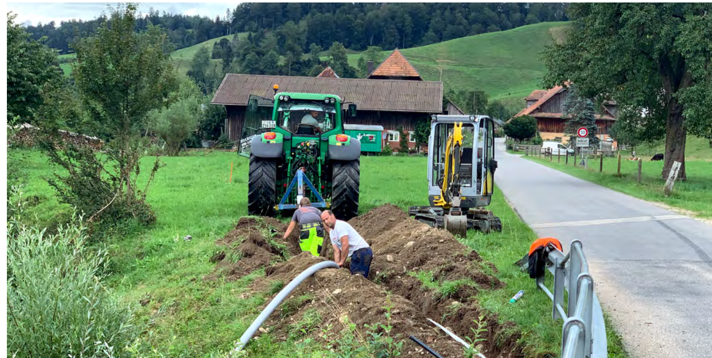
In der Pilotgemeinde Luthern konnte das neue Glasfasernetz zusammen mit lokalen Unternehmen bereits fast vollständig unter Boden verlegt werden. Bild: GFA Luthern
